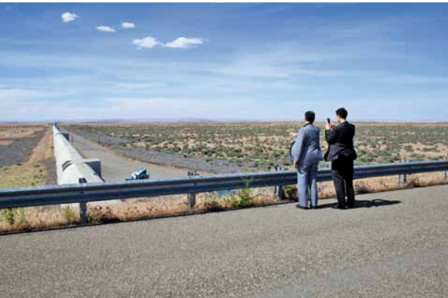
▲ Ein Blick auf das Interferometer-Rohr des Hanford-Systems.
